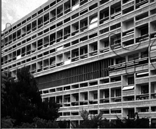
Le Corbusier's Unite d'Habitation, Marseille (1952)
