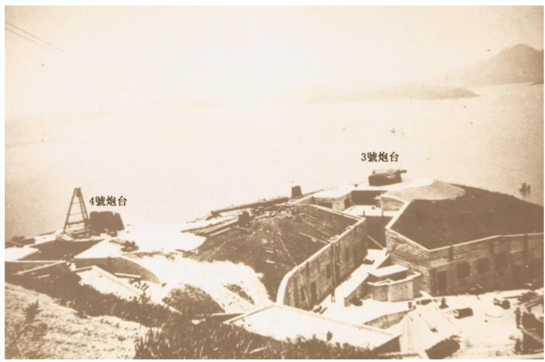
圖中顯示興建中的 3 號和 4 號炮臺，位於現時的青年旅社前面。
