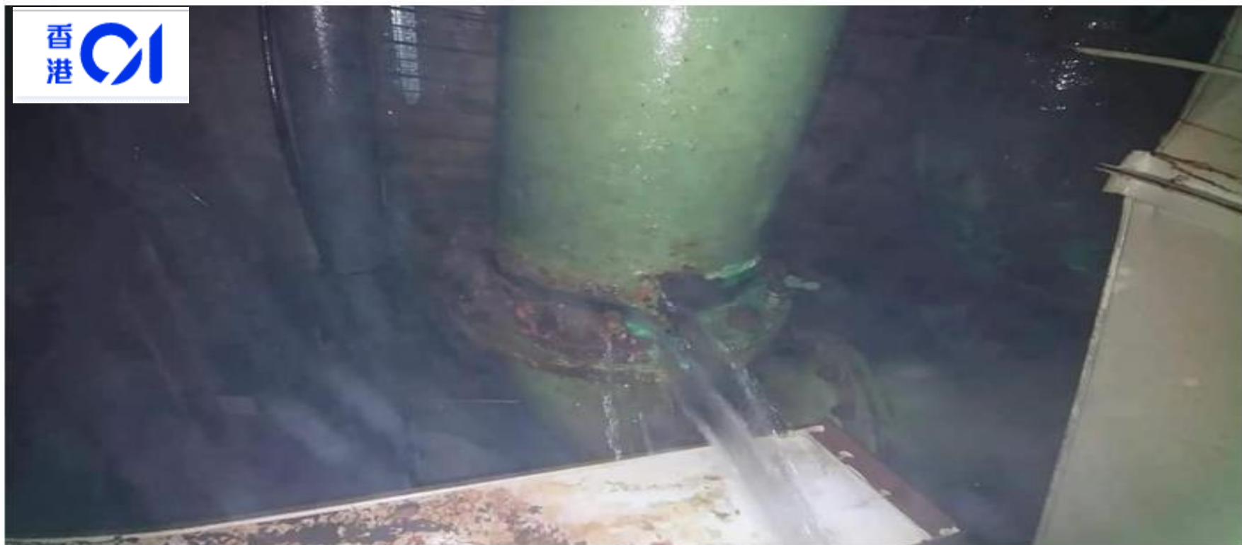
相片則可見有喉管爆裂，令大量的水湧出。（網上圖片）
