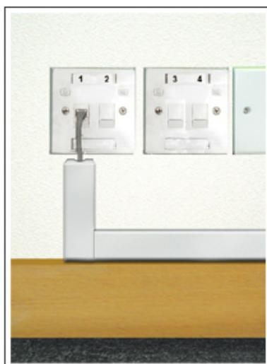
在佈線時，也可將纜線管路直接埋在牆內（通常在新的建築物或辦公室大樓較常見）。爲了讓使用者找到這些隱藏在牆壁內的網絡線，管路出口通常都設有上結點插座。要把電腦連接，用戶只需把網絡線的 RJ-45 接頭直接插入結點插座上。
