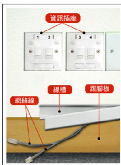
安裝好線槽後，就可以將網絡線放入線槽。用戶應預留一部份網絡線在線槽外，以預防日後移動電腦位置時，還有多餘的網絡線長度作後備。完成後，再蓋好線槽即可。
