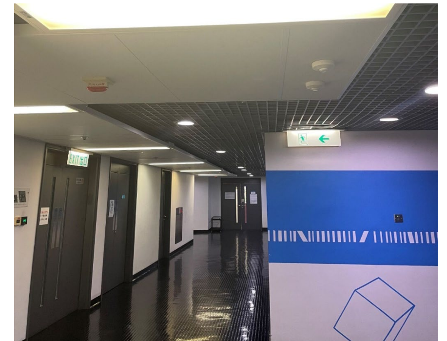
图 26：教育局九龙塘教育服务中心于二零二一年提升照明系统，改用节能的发光二极管
