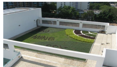
四樓綠化天台
