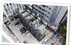
深圳奇異科技公司興建的垂直循環式立體車庫，專科設備佔用節省半車位空間，高 7 層，共可停 12 至 16 部車。
